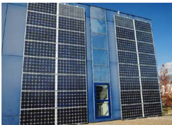
Φωτοβολταϊκός Σταθμός 5,4 KW στο κτήριο της Τράπεζας στη Λ. Συγγρού 87
